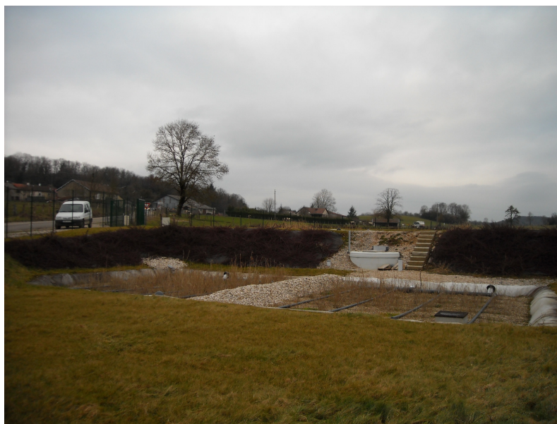
Station d'épuration de VILLENEUVE LES CHARNOD
